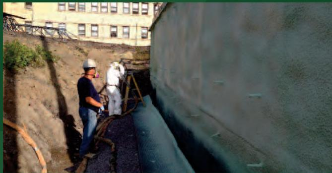
⬡ La photo de gauche démontre un enduit bitumineux appliqué directement sur la mousse de polyuréthane. La photo de droite démontre une membrane de drainage qui sera remontée devant la mousse de polyuréthane en même temps que le sol sera remblayé.
