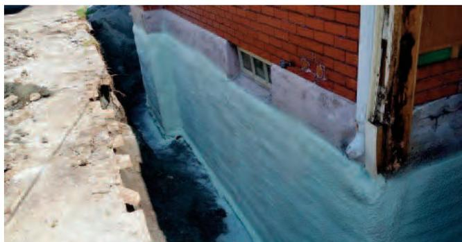
⬡ Lorsqu'on excave une vieille fondation, c'est le moment idéal pour l'isoler de l'extérieur avec la mousse isolante giclée Airmétic.
