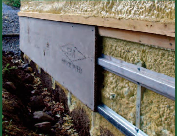
Exemple du détail de la partie hors-sol de la fondation durant la construction.
